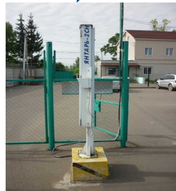
Система радиационного контроля ЯНТАРЬ-2СН
