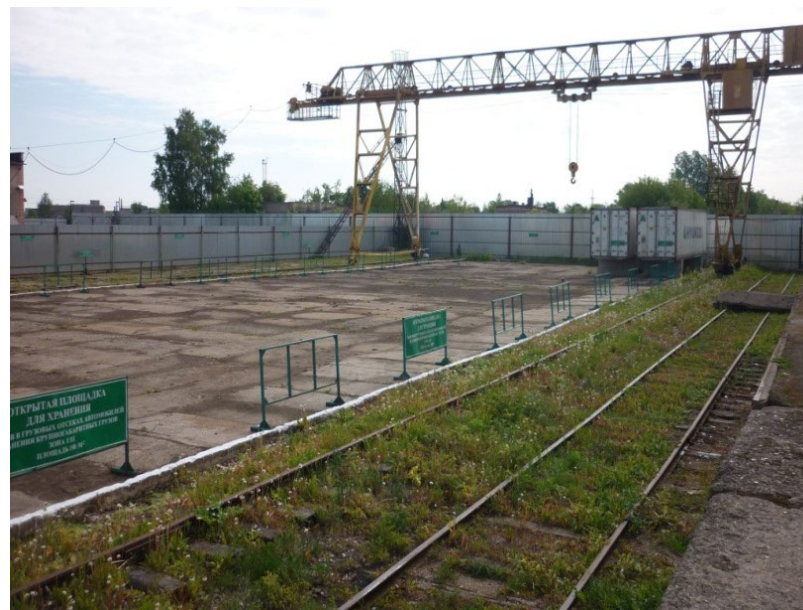
Контейнерная площадка для приема 200 крупнотоннажных Ж/Д контейнеров
